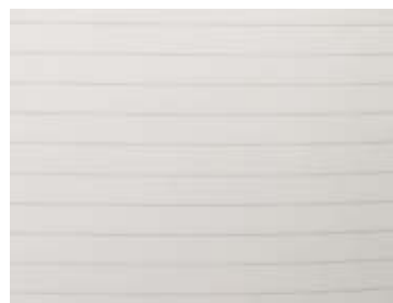
NB230, NB231 Detail Innenansicht
